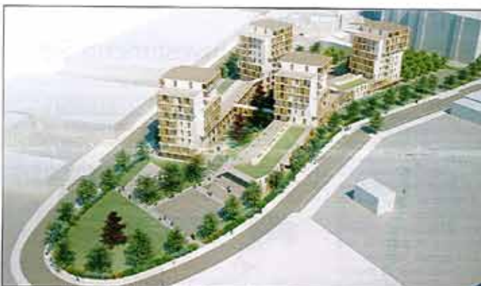
Il complesso di via Conni a Milano, 130 alloggi con servizi commerciali e integrativi e struttura interamente in legno su progetto di Rossi Prodi Associati, è uno degli interventi del Fondo Abitare Sociale 1 promosso da Fondazione Housing Sociale di Milano
